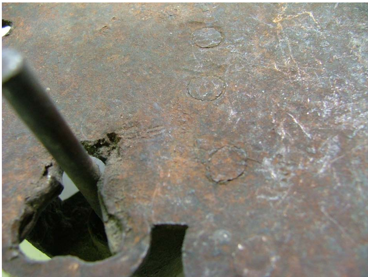
Obr. 3. Zadní strana zámku - podložní plech. Detail korozních produktů u vodícího mechanismu dutého klíče a zapuštěné nýty. Detail deformace na podložním plechu u vodícího mechanismu klíče.
