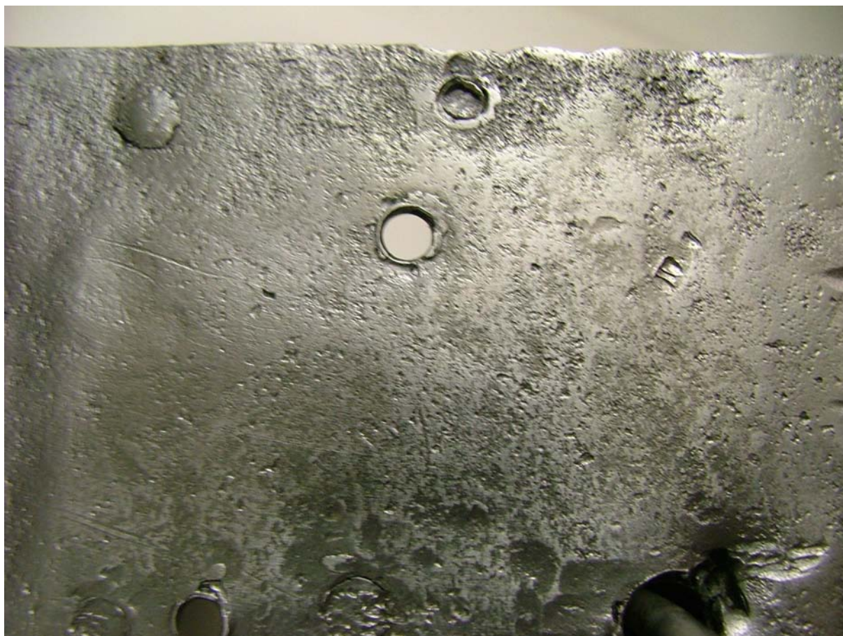
Obr. 26. Detail podložního plechu – odstranění koroze. U nýtu je patrná zakonzervovaná důlková koroze. Montážní probíjený otvor o průměru 5 mm.
