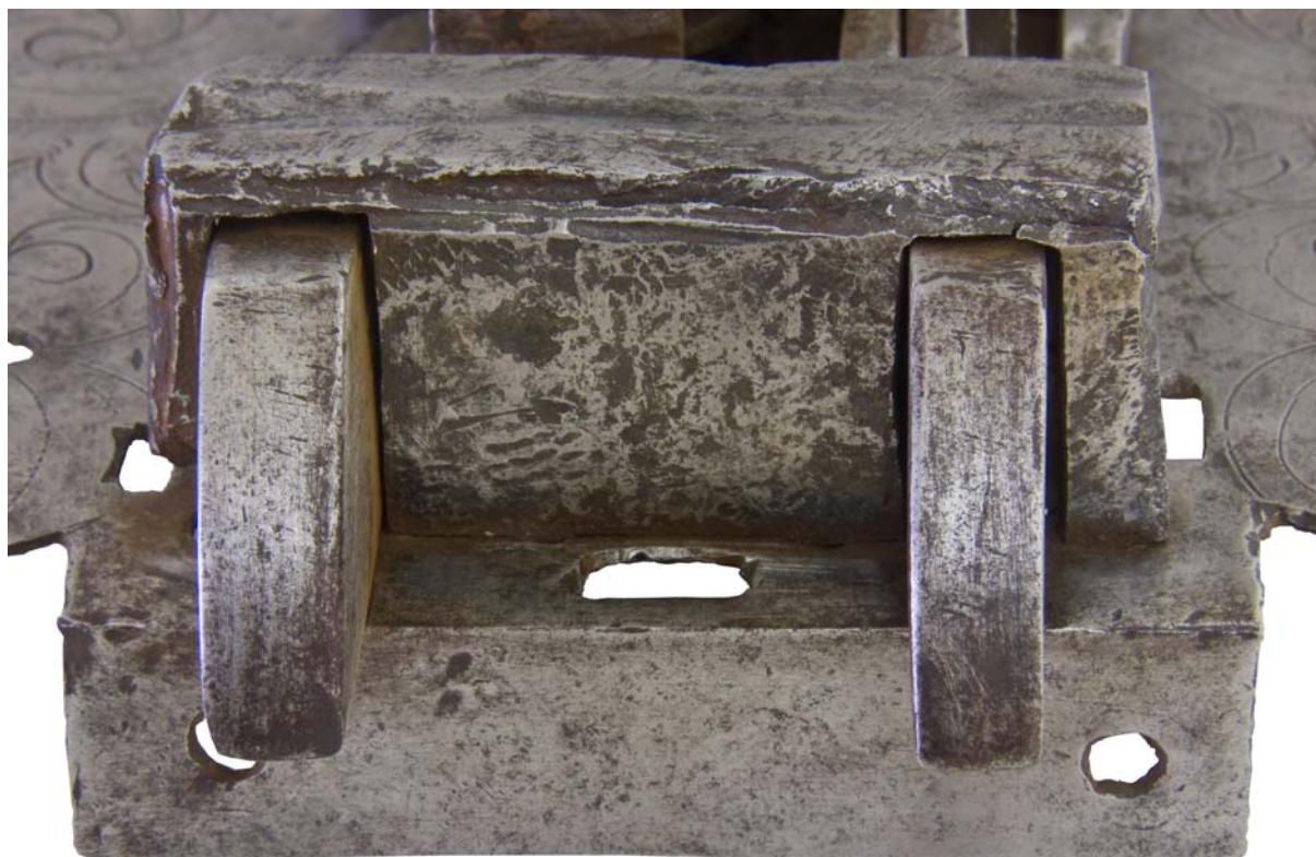
Obr. 18. Čelní L-profil závor je k podložnímu plechu přinýtovaný. Na levé straně vedle levé závory chybí jistící nýt. Nýt byl pravděpodobně vylomen. Čelní L-profil jistí k podložnímu plechu další 3 nýty. Tyto nýty jsou stabilní, jistí čelní L-profil závor.
