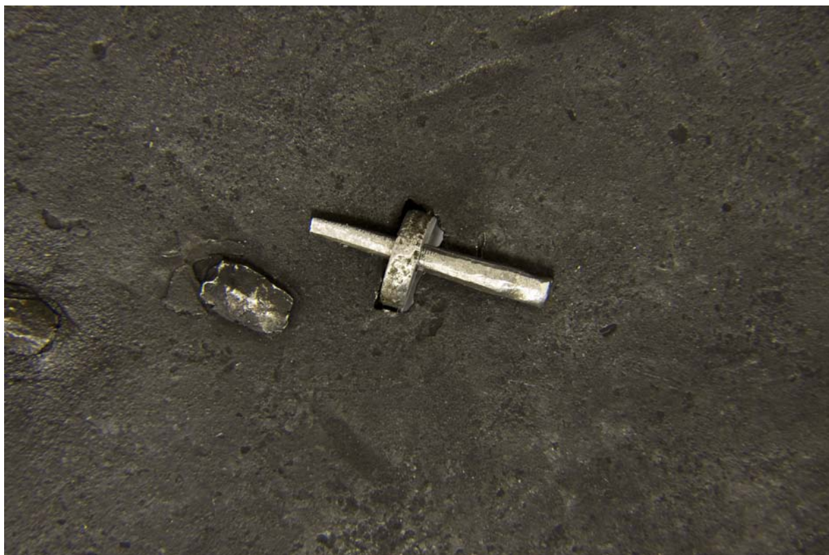
Obr. 51. Detail – závlačka (klínek), jistící obdélnou kazetu na nepohledové straně podložního plechu. Vedle je zapuštěný nýt.
