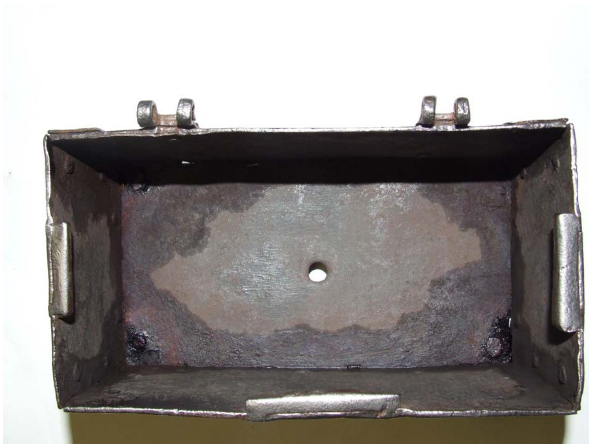
Obr. 43. Vnitřní stana – lokální tanátování roztokem Tanátu A v nejpostiženějších místech. Do prasklin a mezi plechy se roztok Tanátu A byl injektován.
