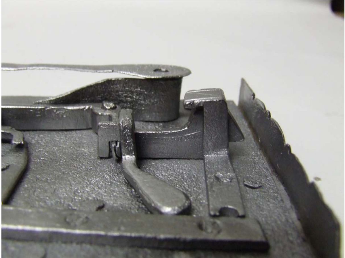
Obr. 24. Přídržný vodič závor, boční závora po zakonzervování minerálním olejem WD 40 s včelím voskem.
